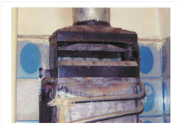
Nevarnost: Zelo umazan/zasajen plinski kotel
